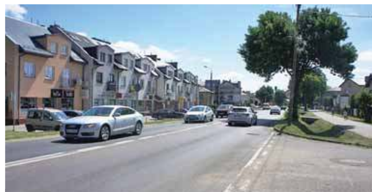
Główna ulica miasta będzie wyremontowana do października br.
