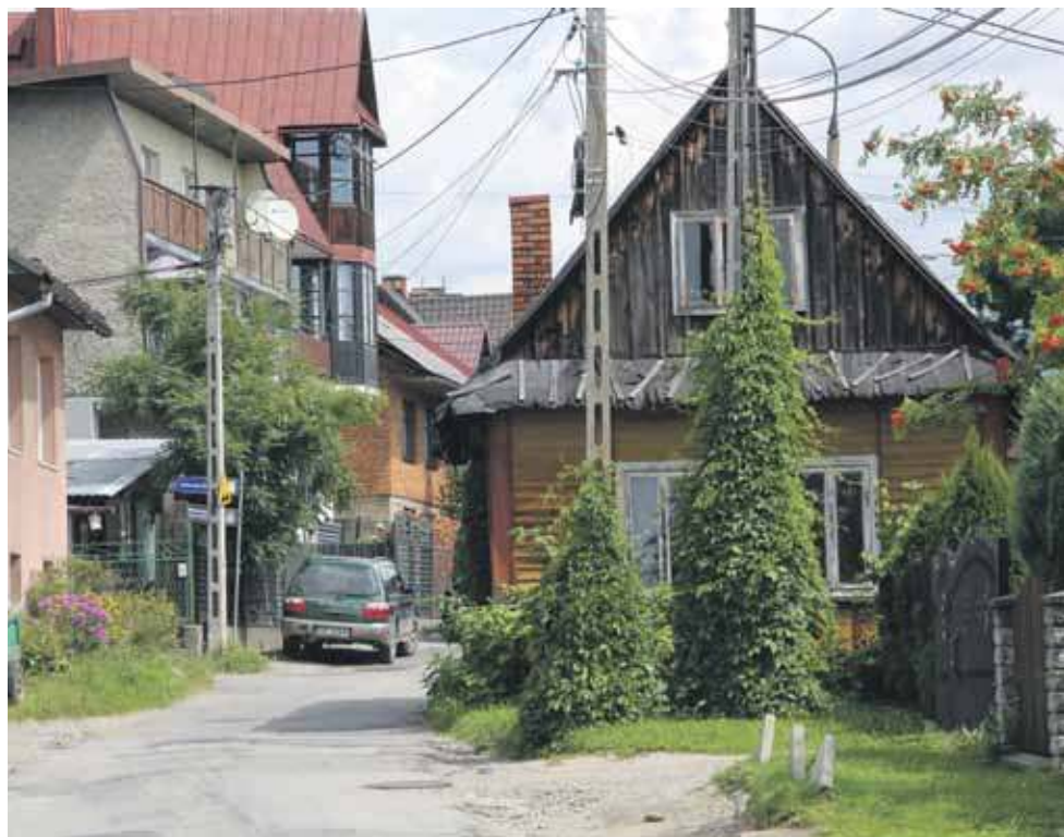
Ustronie - drewniany dom wchodzący w drogę ma zostać zburzony.
