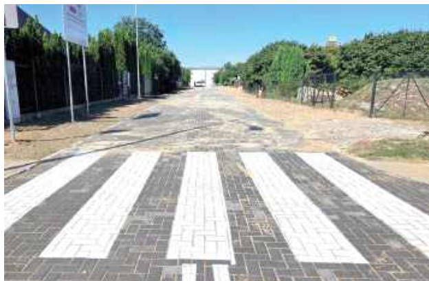
Ulica Jakuba Staszewskiego w Łęcznej po pracach remontowych
