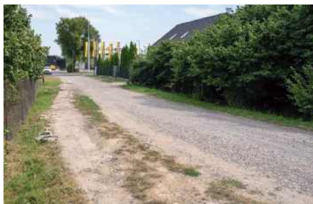
Ulica Jakuba Staszewskiego w Łęcznej przed remontem
