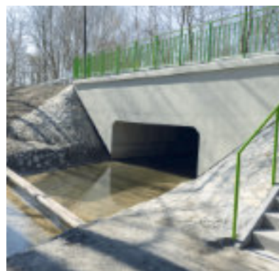
► Przebudowany przepust Fot. UM Zabrze
