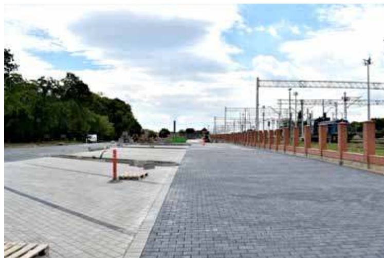
Układana jest nawierzchnia miejsc postojowych dla autobusów
