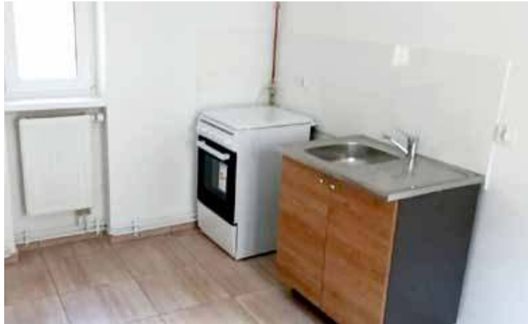
W mieszkaniach wykonano instalację centralnego ogrzewania
