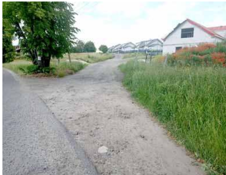
Po opadach deszczu powstaje w tym miejscu sporo błota, co utrudnia znacznie poruszanie się
