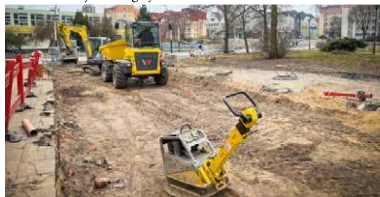
Droga na ul. Spichrzowej jest obecnie w trakcie remontu. Fot. Sebastian Ler.
