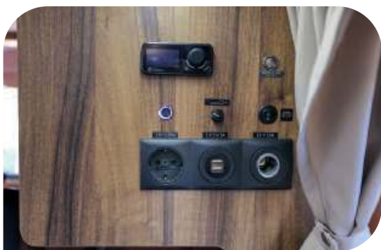
Centrala świetlna-energetyczno-grzewcza; tutaj włączamy inwerter, oświetlenie, ogrzewanie postojowe oraz ładujemy telefony z gniazd USB
