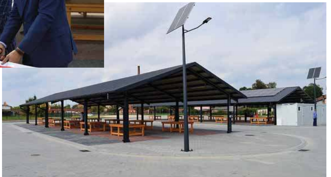
Zmodernizowany obiekt posłuży lokalnym handlarzom i społeczności.
