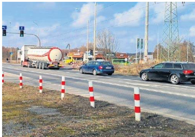
Inwestycja wyprowadzi ruch pieszych i rowerzystów poza jezdnię, na której jest duże natężenie ruchu.
