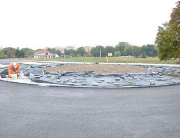
Mieszkańcy Radzyna już są zniercpliwieni oczekiwaniem na zakończenie budowy ronda przy Urzędzie Skarbowym. Inwestycja za prawie 800 tys. zł ma rondo ok. 25 metrów średnicy i wydawać się mogło, że pójdzie gładko. Jednak nie...
