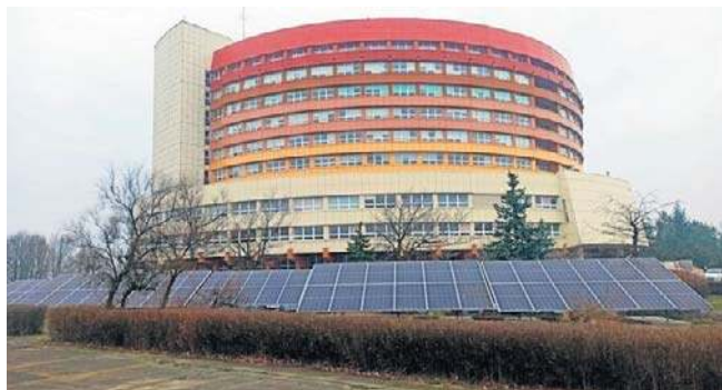
Zastrzeżenia kontrolerów dotyczą między innymi budojny farmy fotowoltaicznej przy szpitalu w Kaliszu
