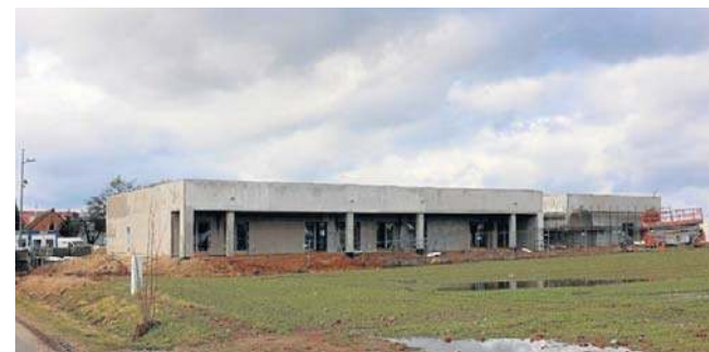
Na placu budowy byliśmy w lutym
