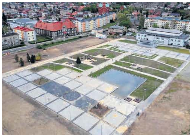
Rynek z lotu ptaka. Trzy wyraźnie widoczne pierzeje mają zostać w przyszłości zabudowane przez 21 kamienic
