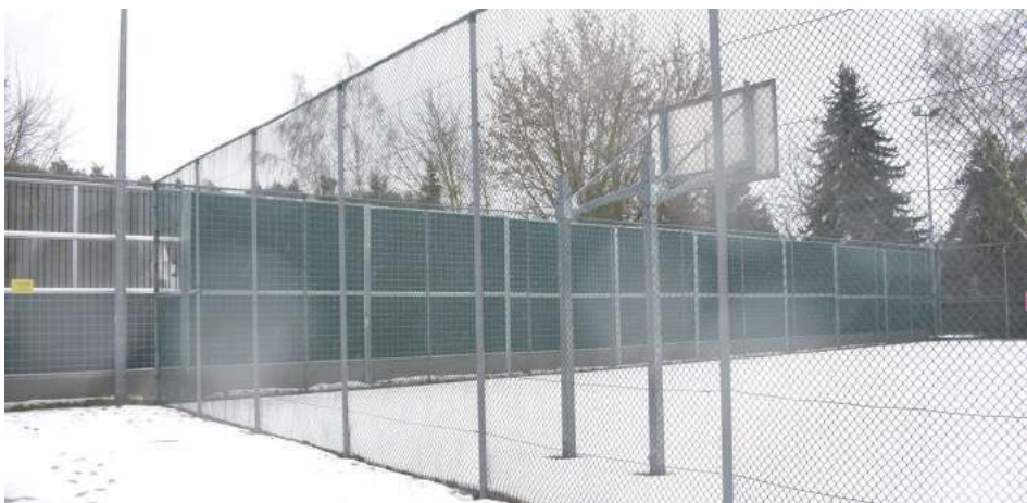
Miasto, aby ograniczyć przenikanie hałasu z boiska na działkę małżeństwa, wybudowało ekrany akustyczne. Ale teraz, oprócz hałasu, sąsiadom „Orlika” przeszkadzają i one, bo ich zdaniem zaciniają ich działkę
