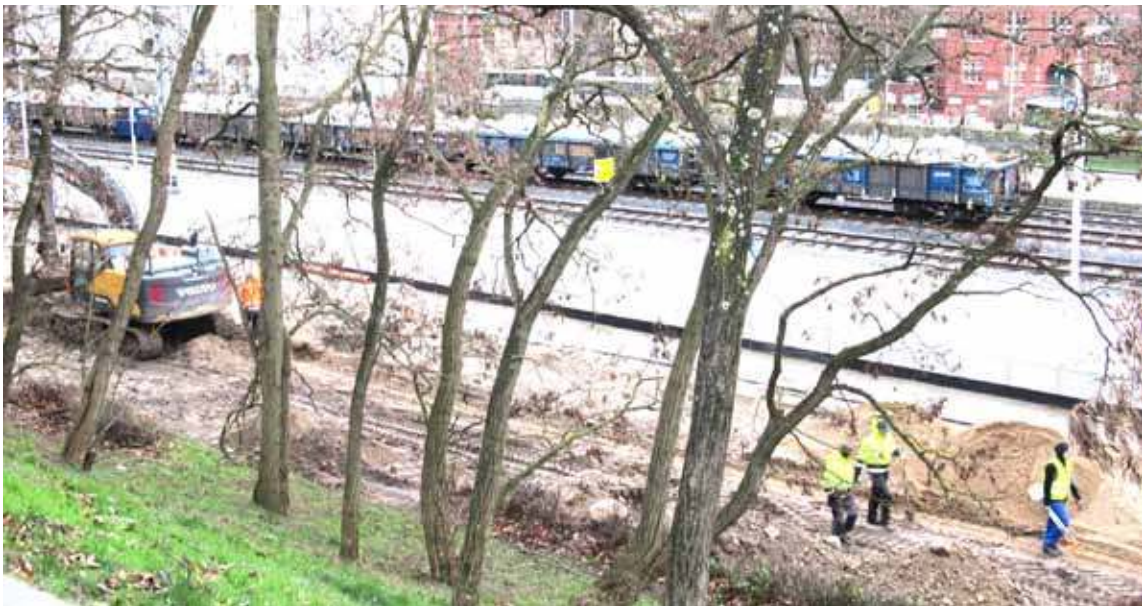
Prace na przebudowie ul. Kolejowej trwają, a na dworcu PKP - zamarły.
