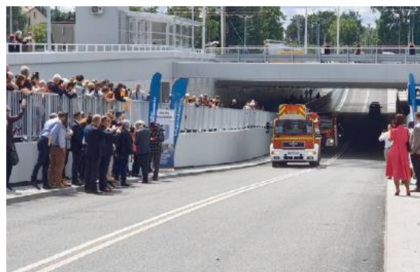
Nowy tunel to kolejna istotna modernizacja infrastrukturalna.
