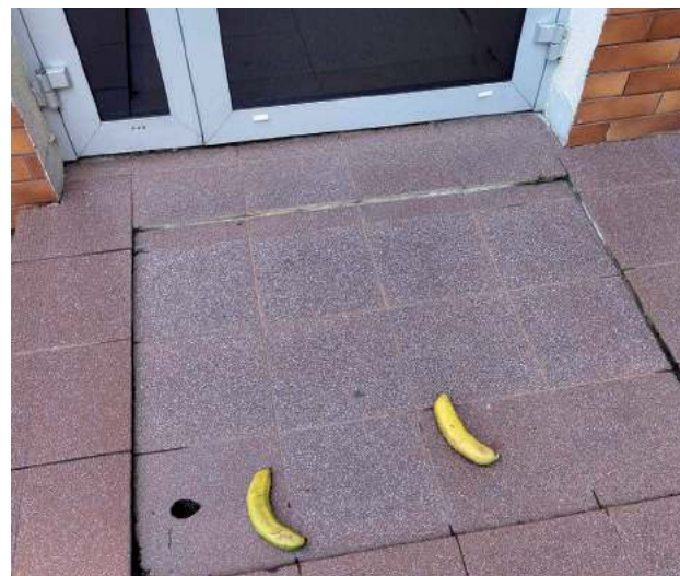
„Banany były wszędzie: pod salą gimnastyczną, na regałach w bibliotece i niestety na zewnątrz budynku” - napisała dyrektorka szkoły w Tuchowiczu na Facebooku
