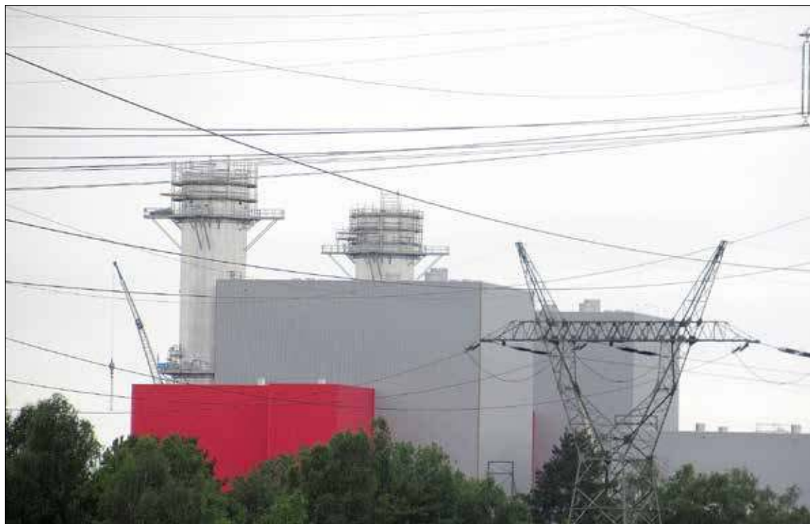
Obiekty nowej elektrowni prezentują się efektownie
