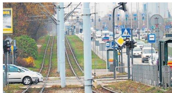
Torowisko na ul. Aleksandrowskiej zostanie przebudowane. Zmieni się także dojazd do dworca Łódź Żabieniec
