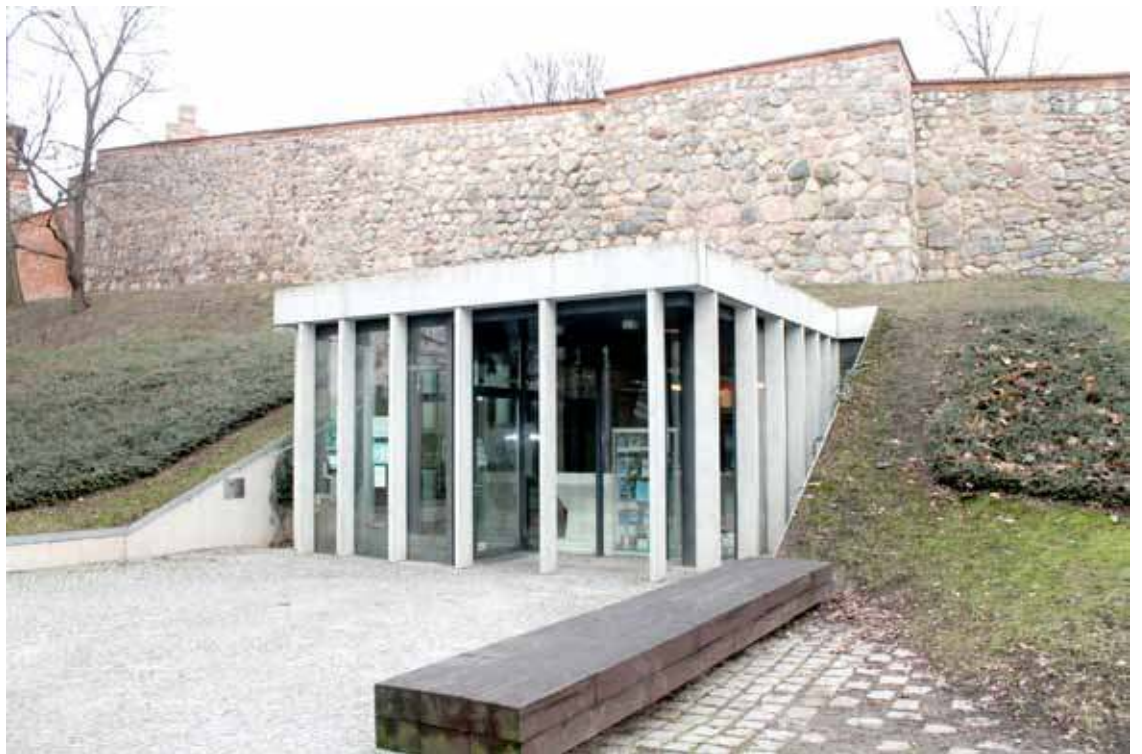
Po wypadku w Koszalinie także Escape Room w stargardzkiej Bastii został skontrolowany przez Państwową Straż Pożarną oraz Nadzór Budowlany
