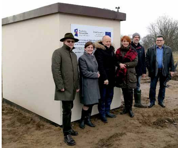
Obie instalacje wyposażone są w bank energii o pojemności 500 kWh
