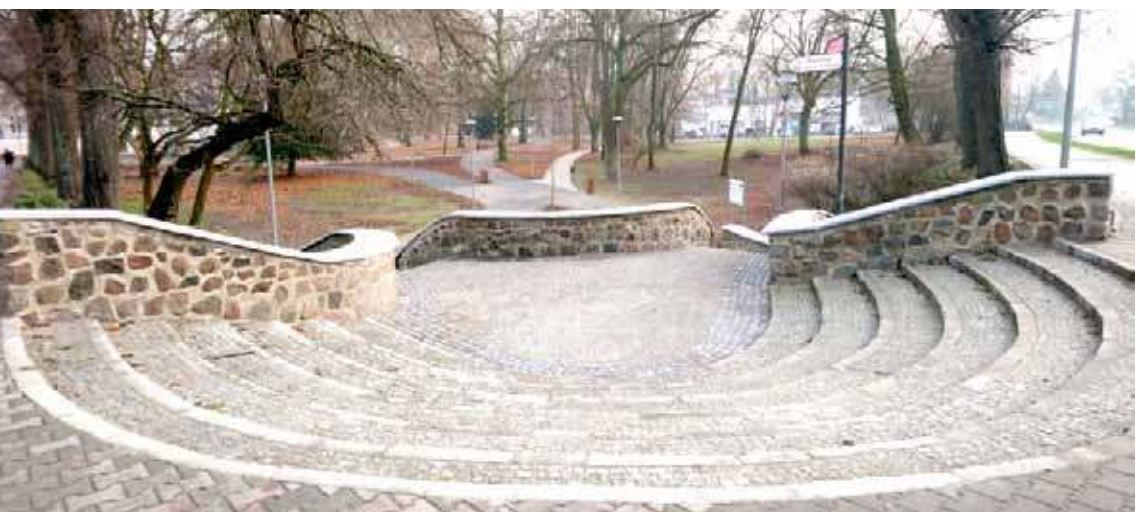
Wyremontowano również zabytkowe, amfiteatralne schody
