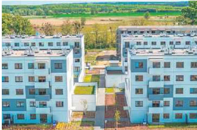
Zwróć uwagę na rozmaite detale, by uniknąć kłopotów i... kosztów już po przeprowadzce
