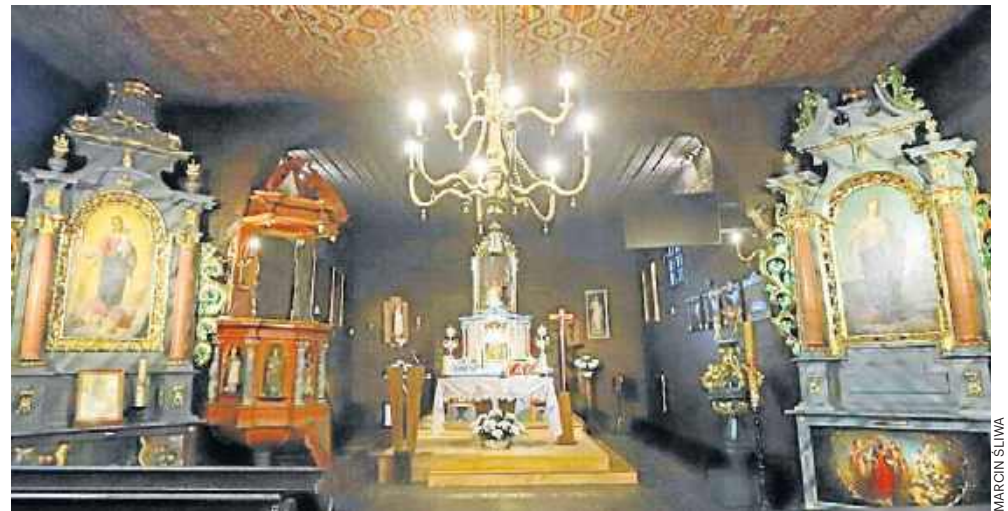
W ostatnich latach wnętrze kościoła św. Wawrzyńca przeszło remont. Pierwotne kolory odzyskały m.in. ołtarze boczne Matki Bożej Różańcowej i św. Barbary
