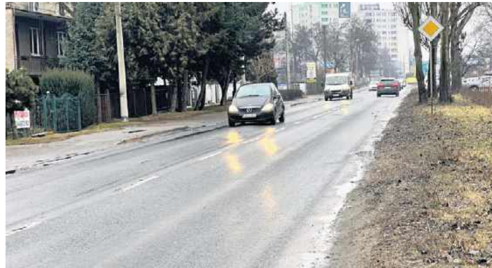
Wyremontowany zostanie odcinek ul. Grota-Roweckiego od S86 do granicy z Czeladzią
