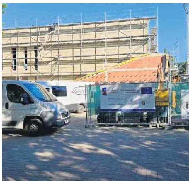
Prace ruszyły przed jesienią 2024 roku i przebiegają w ekspresowym tempie
