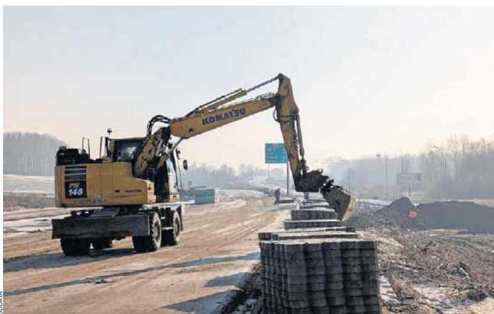
Tak powstaje na północy Polski nowa trasa, która finalnie dotrze aż do województwa śląskiego, a na górnym zdjęciu widać istniejące już odcinki S11
