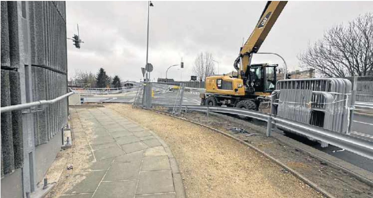
Nowym wiaduktem nad torami najprawdopodobniej pojedziemy już na Wielkanoc. Na placu budowy trwają ostatnie szlify.
