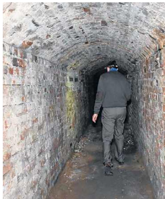
Szczelina przeciwlotnicza ma 60 metrów długości
