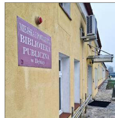
Budynek powstał pomiędzy 1881 a 1885 rokiem.
