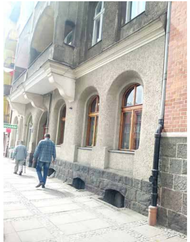
STBS zapowiada modernizację budynku przy ul. Hetmana Stefana Czarnieckiego 19
