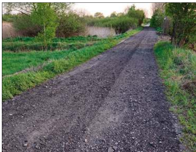
Tak prezentuje się wysypana frezowinami asfaltowymi droga na tzw. Gold.
