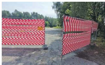
Brama na parkingu przy cmentarzu w Sierszy postawiona przez wykonawcę prac
