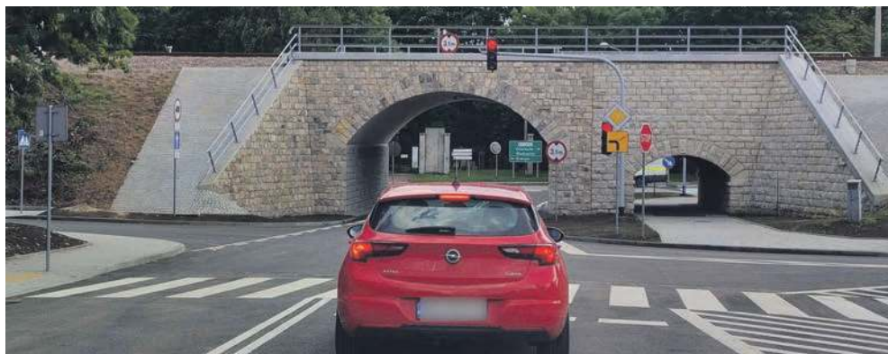
Zmodernizowany wiadukt na ul. Siennej w Chrzanowie
