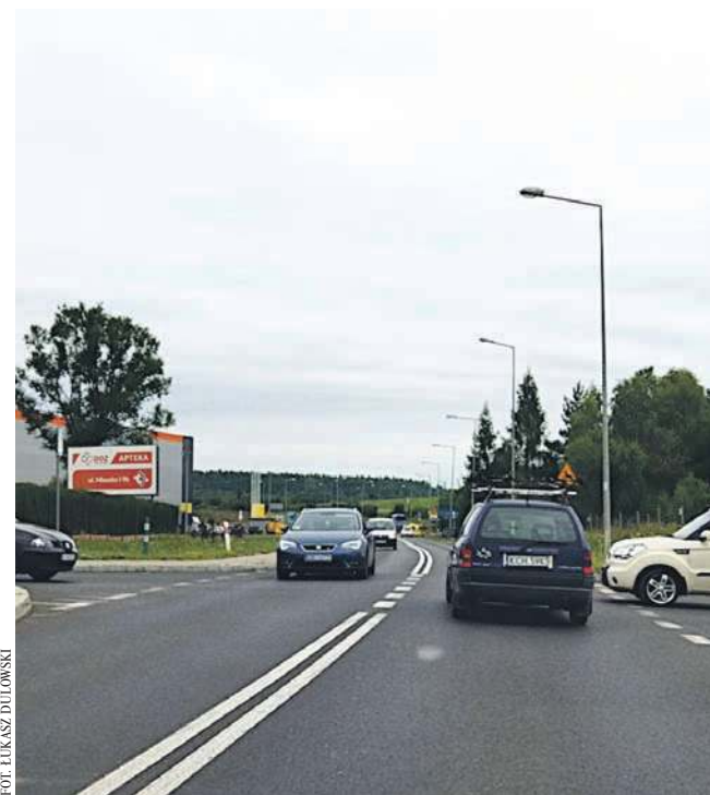
Skrzyżowanie ul. Garbienia (obwodnica) i ul. Okrzei w Chrzanowie
