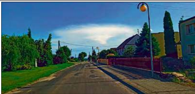
Skanalizowana zostanie cała Oleszka, m.in. ul. Kościuszki.
