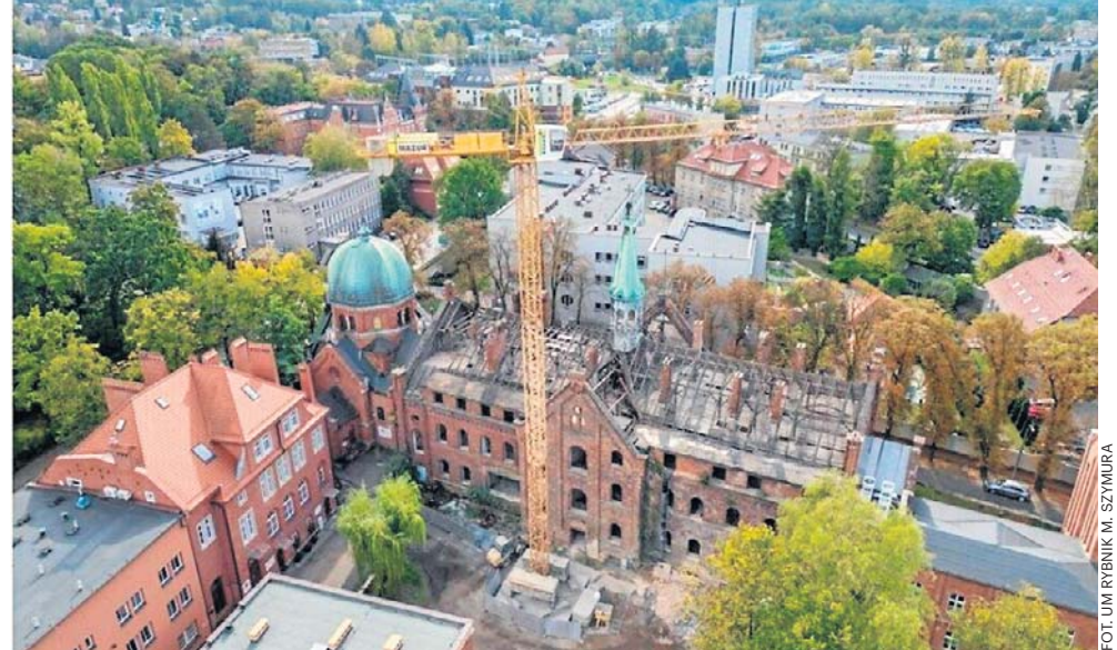
Trwa rewitalizacja dawnego Szpitala Miejskiego nr 1 w Rybniku, zwanego „Juliuszem”. Podczas robót budowlanych został wykorzystany także żuraw
