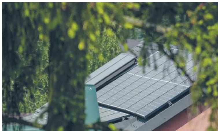
„Odnawialne źródła energii” – instalacja fotowoltaiczna
