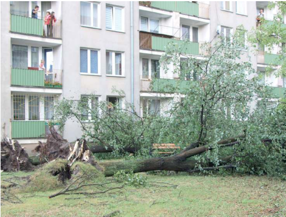
Drzewa wyrwane z korzeniami przy ul. Lipowej
