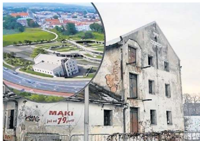
Przy Starym Młynie Jezuickim w Nowym Sączu prace modernizacyjne już się rozpoczęły
