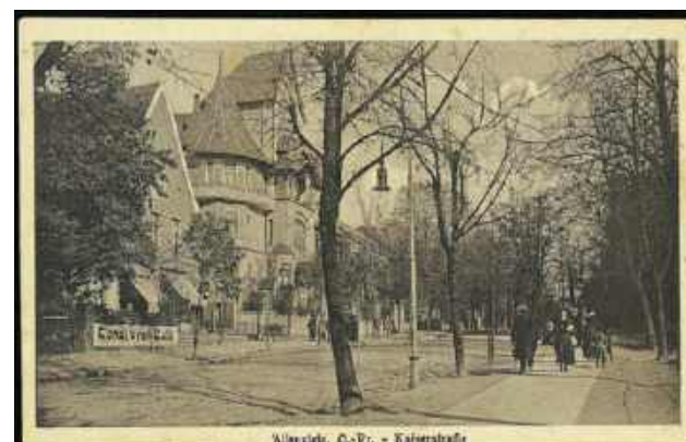
Kamienica Naukacka przy ul. Dąbrowszczaków (ok. 1918 r.)
