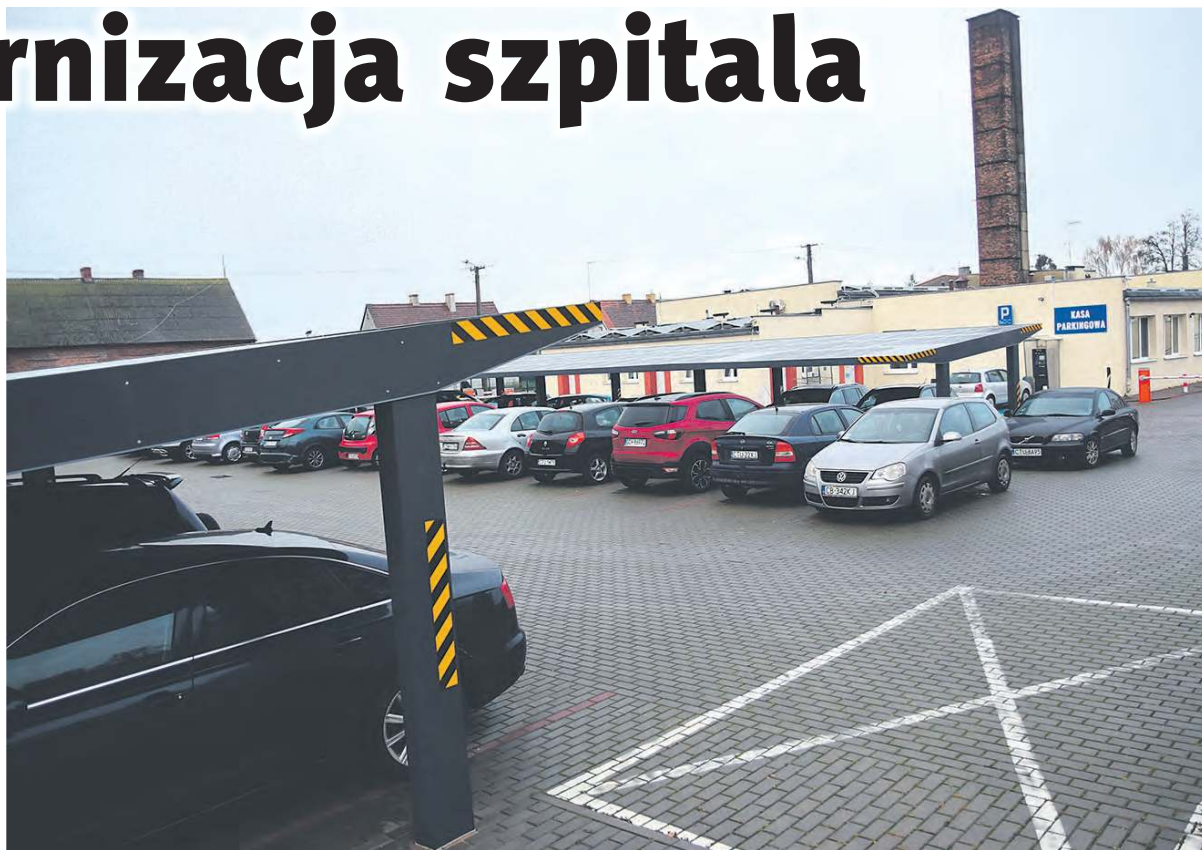
Na parkingu szpitalnym postawiono wiaty.
