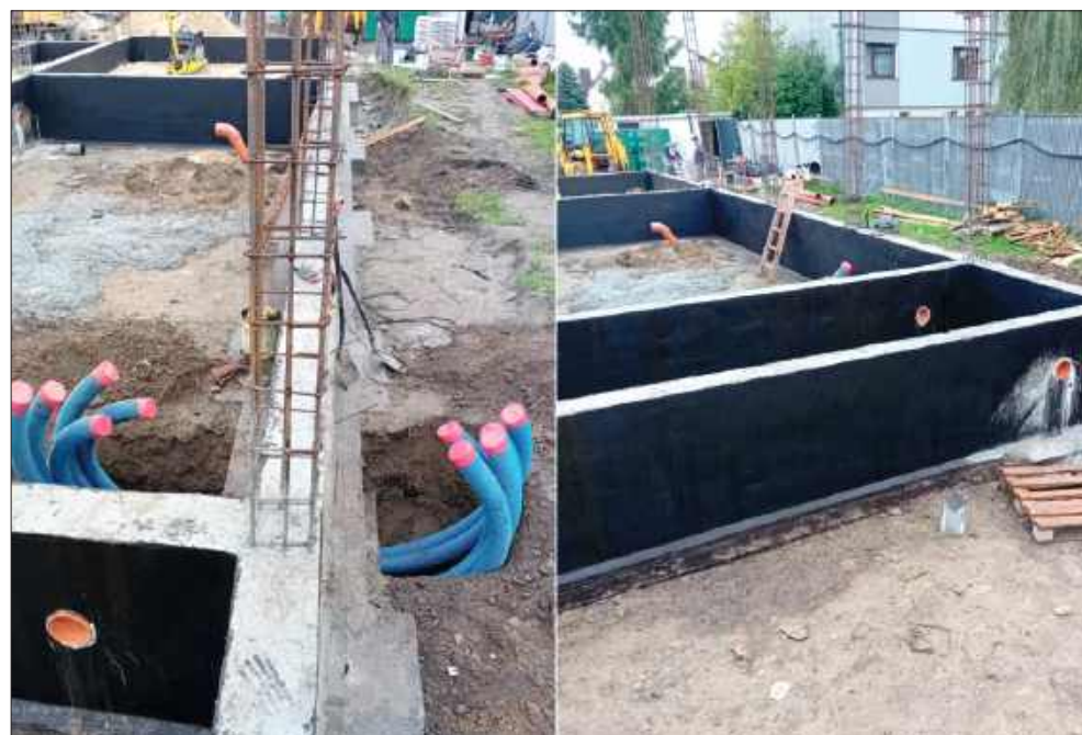
Tak obecnie wygląda plac budowy.
