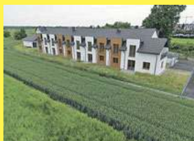
2 segmenty w nowoczesnej zabudowie szereowej, w stanie deweloperskim w Łukowie przy ul. Gospodarskiej, 885 851 158
