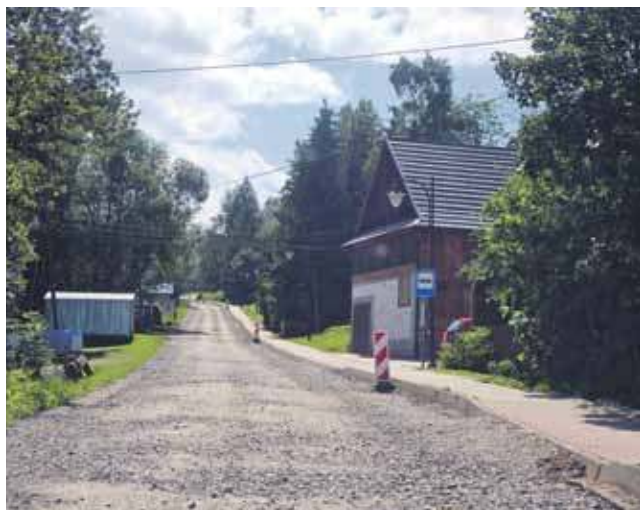
Remont ul. Halnej w Brzegach sprawia, że nie dojeżdżają tam busy.
