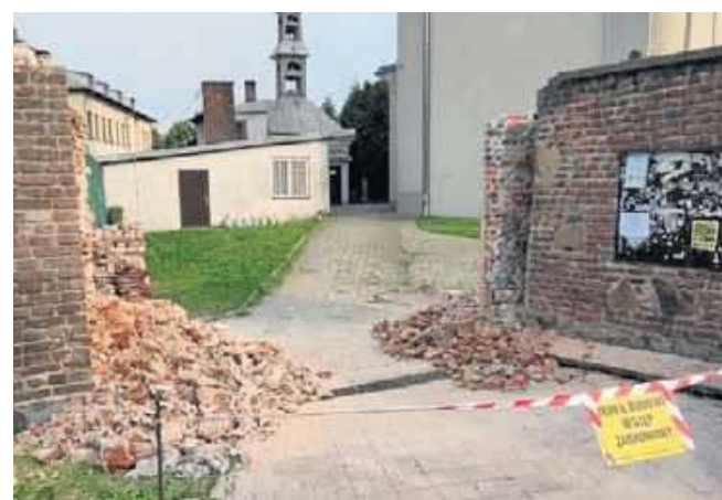
Pozwolenie na remont zostało wydane przy zachowaniu rygorystycznych ograniczeń
