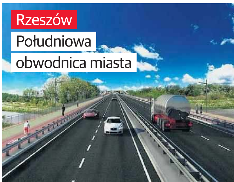
FOT. ARCHIWUM FIRMY SWECO MED RZESZÓW
