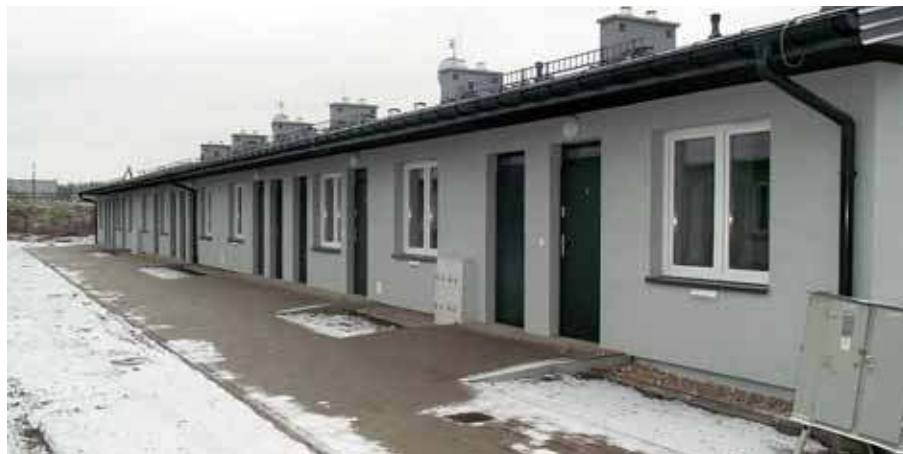
Nowo zbudowany dom komunalny z 14 mieszkaniami
