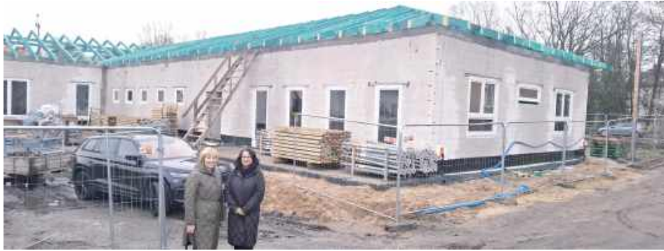
Po zakończeniu prac obiekt stanie się nowoczesną, bezpieczną i w pełni dostosowaną do potrzeb dzieci przestrzenią, znacząco zwiększając możliwości opieki żłobkowej i przedszkolnej w naszej gminie
