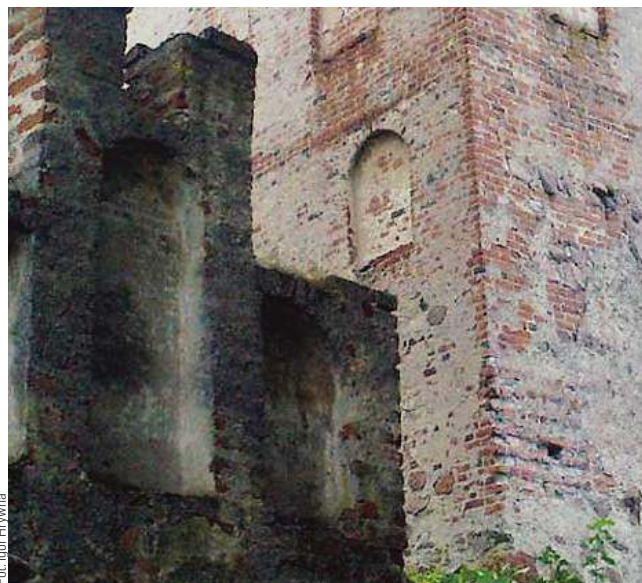
Kielich miał zostać zamurowany w ścianie kościoła
