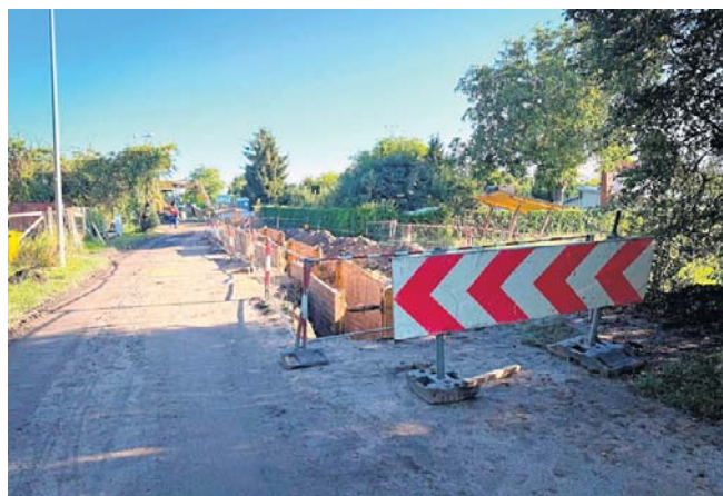
Ekipy kompleksowo przebudują układ drogowy obu ulic
