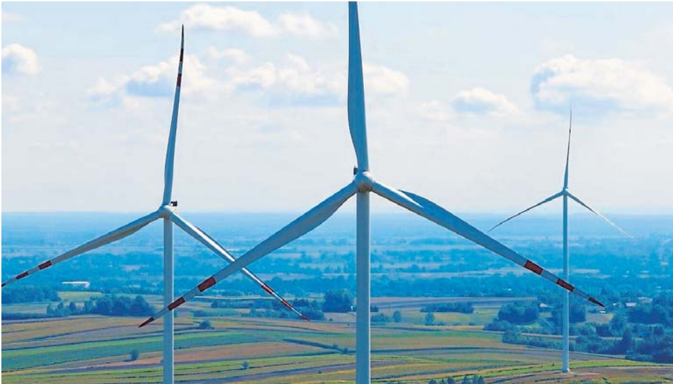
Transition Technologies-Systems i Enea wdrażają jeden z największych w Polsce systemów do zarządzania OZE i magazynami energii.
