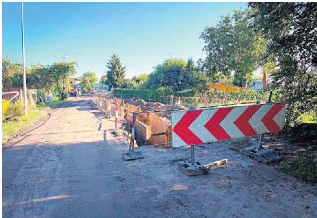
Ekipy kompleksowo przebudują układ drogowy obu ulic
