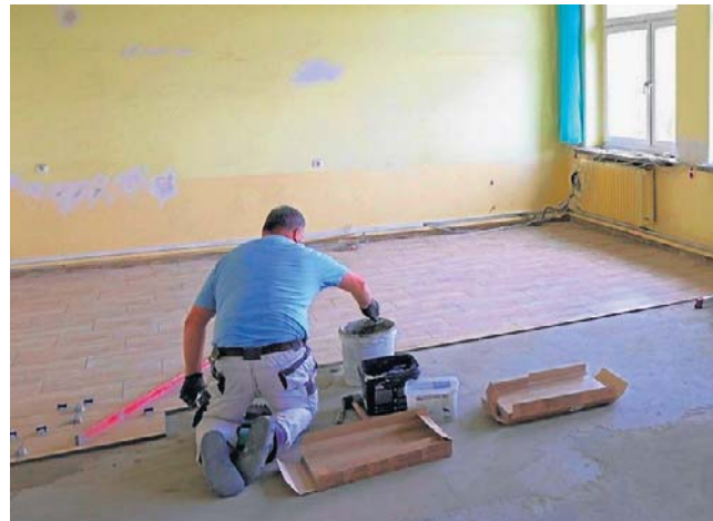
Przebudowa i odświeżanie sal lekcyjnych, remonty podłóg i dachów. Te prace wykonują ekipy remontowe
