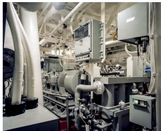
▲ Wnętrze maszynowni z układem elektrycznego przeniesienia mocy — przykład architektury CODLAG/IFEP.
