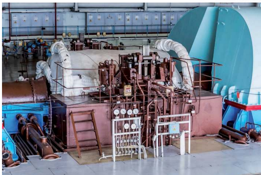
▲ Turbina parowa dużej mocy stosowana w elektrowniach i okrętowych siłowniach jądrowych.
