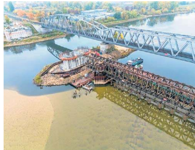
Na Moście Tczewskim zakończono skomplikowaną operację opuszczania ponad 125-metrowego stalowego przesła ESTB
