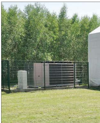
Ten agregat obsługuje lodowisko – rockowisko
