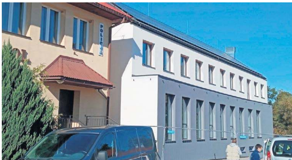
W gminie Fredropol przeprowadzono sporo inwestycji. Na zdjęciu widoczna jest rozbudowa budynku gminnego, w którym powstała m.in. sala widowiskowa
