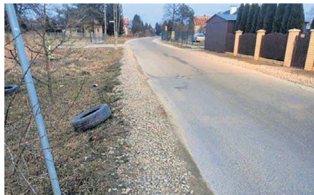
Ulica na os. Gądkki jest w fatalnym stanie, pędzące samochody rozjeżdżają pobocza i przydrożne ogródki
