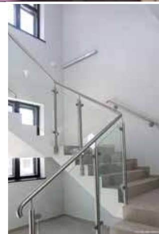
Klatka schodowa - po remoncie
