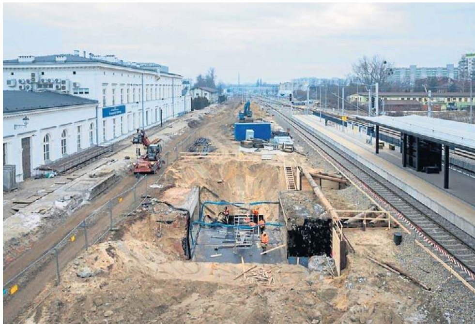
Tak wygląda obecnie budowa nowych peronów na stacji Sosnowiec Główny
