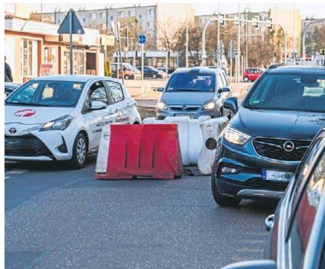
Wygradzenie na jezdni ustawiono na początku marca
