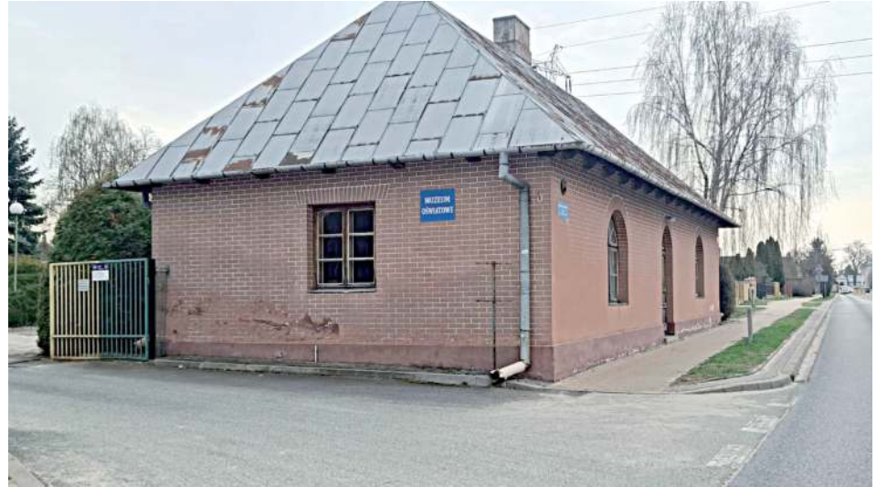
To właśnie tu w tym niepozornym budynku mieści się Muzeum Oświatowe w Puławach. Budynek znajduje się przy drodze wojewódzkiej nr 824, którą z Puław jedzie się m.in. do Kazimierza Dolnego
