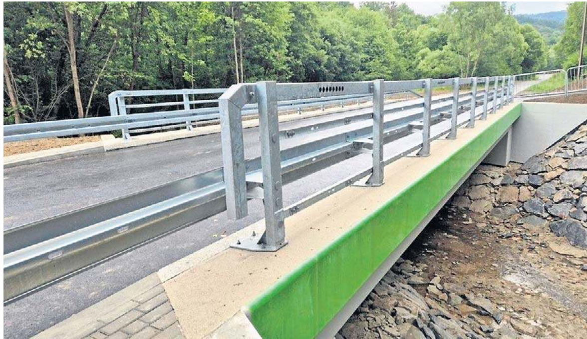
Drugi z wyremontowanych mostów w Bałuciance oddano do użytku mieszkańcom i turystom
