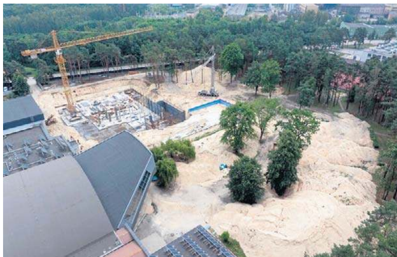
60 procent kosztów budowy aquaparku pochodzić będzie ze wsparcia rządowego (Polski Ład) i unijnego
