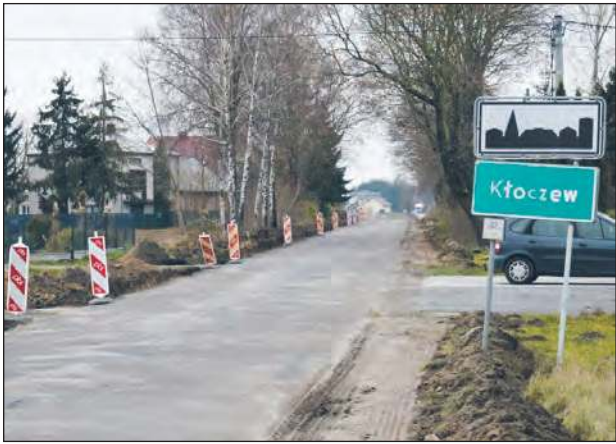
■ Wykopy oraz ustawione oznakowanie jasno wskazują, że inwestycja weszła w fazę realizacji. Jeśli warunki pogodowe będą sprzyjające, kierowcy jeszcze w tym roku będą mogli skorzystać z pierwszej warstwy nowego asfaltu (fot. Powiat Rycki)
